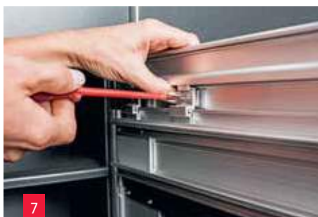
Namensschild und Arretierung durch Anziehen der Schraube befestigen. Schraube nicht zu stark anziehen, ansonsten wird die Front verbogen.
