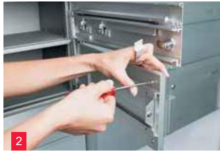
Oberste Schraube auf Innenseite des Paketfaches lösen.
